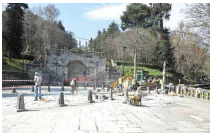
Estão a ser recuperados todos os elementos construídos, incluindo os patamares
