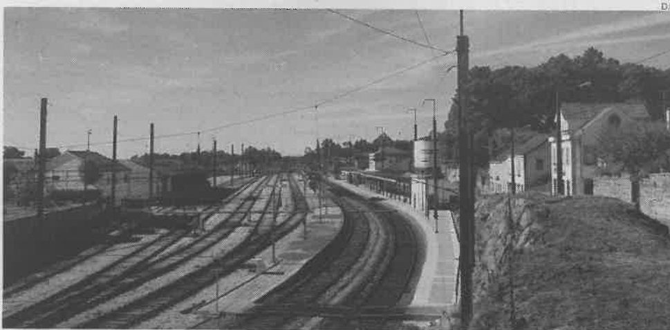
Trabalhos no troço da Linha da Beira Alta têm um prazo de execução de 760 dias
