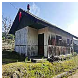
Figura 3 - Habitação em pré-fabricado de madeira
